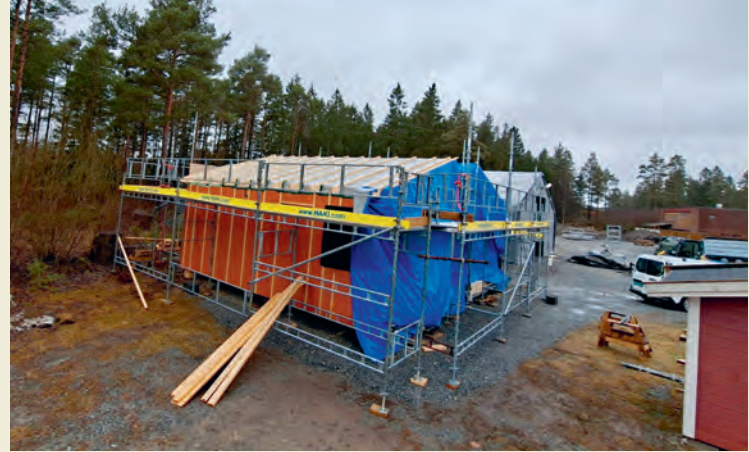
Nye hytter bygges av elever på Østerbo vgs. Foto: Bjørn Petter Åsheim/Østerbo vgs
